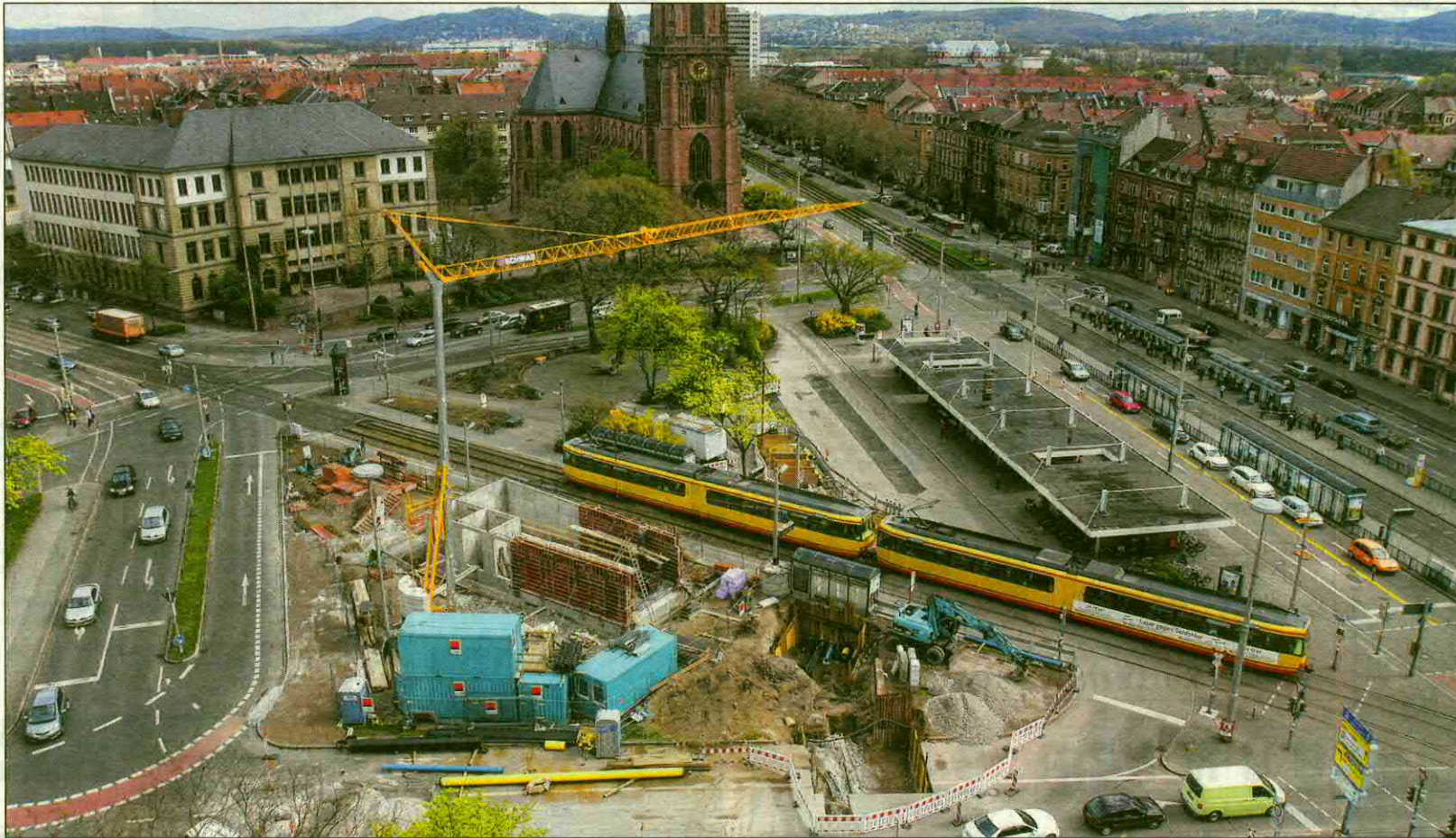
DAS DURLACHER TOR spielt eine Paraderolle im Bauprogramm der Fächerstadt – sechs Jahre, bis 2016, ist es eine Baustelle. Am neuen VBK-Betriebsgebäude wird bereits schwer gearbeitet. Bald kommt der Leitungs-, Haltestellen- und Rampenbau für die U-Strab hinzu.
